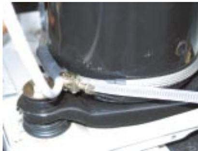
Рис. 2. Установленный картерный нагреватель
